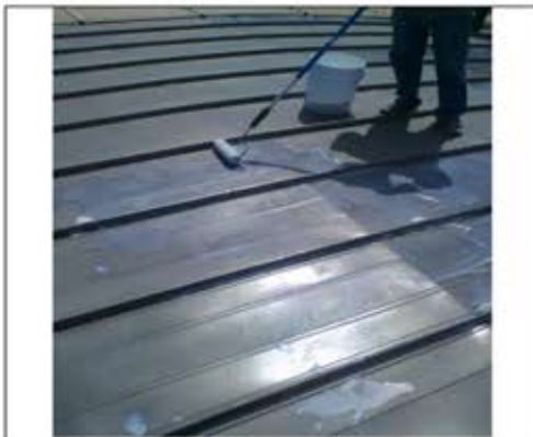
APLICACIÓN DEL PRIMARIO ACRILICO FORZZA SEALANT
