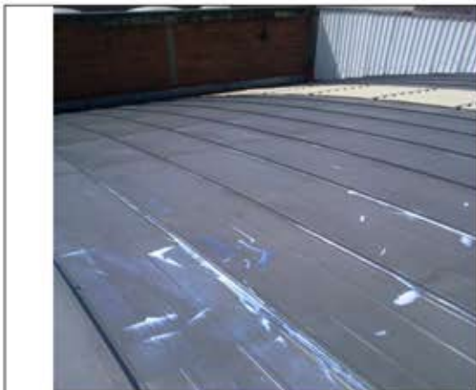
UNA VEZ APLICADO EL PRIMARIO ACRILICO FORZZA SEALANT
