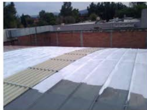
APLICACIÓN DE LA PRIMERA CAPA DE THERMOFORZZA
