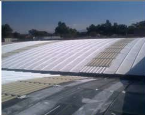
PRIMERA MANO DEL RECUBRIMIENTO THERMOFORZZA
