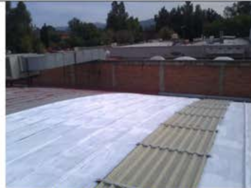
PRIMERA MANO DEL RECUBRIMIENTO THERMOFORZZA
