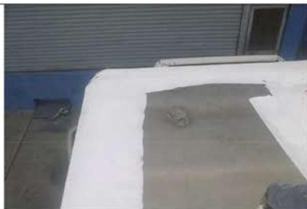
1ª. CAPA DE THERMOFORZZA (PREVIO SELLADO CON PRIMARIO ACRILICO FORZZA SEALANT)
