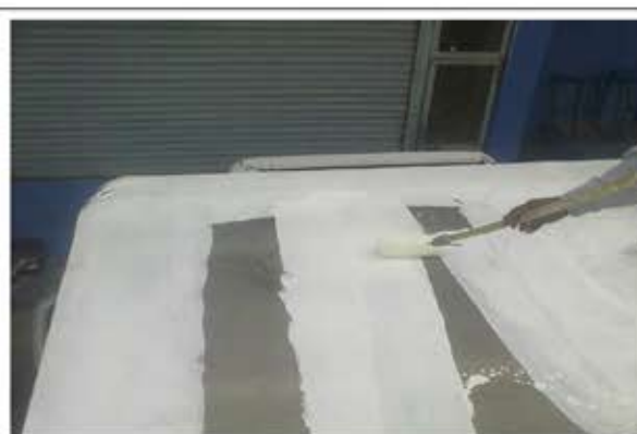
APLICACIÓN DE LA PRIMERA CAPA DE THERMOFORZZA
