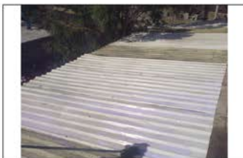
APLICACIÓN DEL PRIMARIO ACRILICO FORZZA SEALANT
